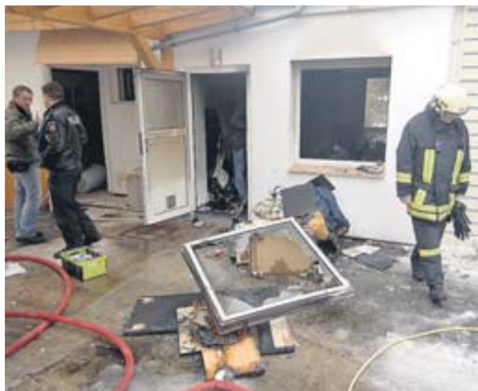
Ausgebranntes Apartment: Ursache des Feuers unklar. Pförtner
